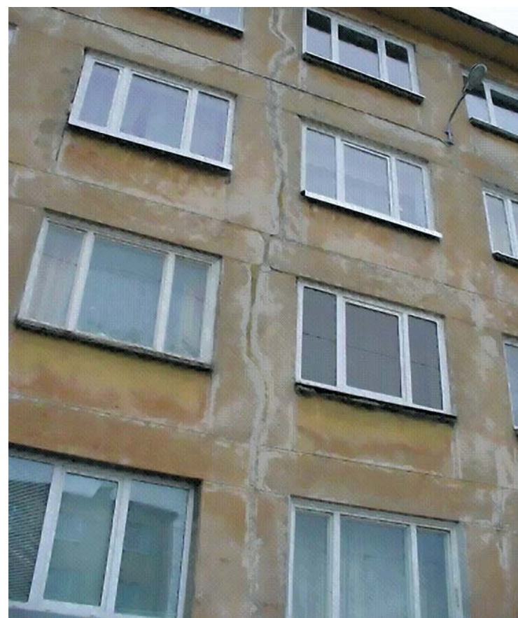
Plaisas betonā: šī no gāzbetona blokiem būvētā māja ir spilgts piemērs tam, ko ar betonu var izdarīt mitrums, ogļskābā gāze, sals un laiks.
