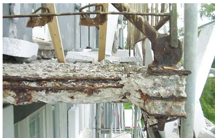
Bīstamība virs galvas: reizēm balkonu stāvoklis ir tik katastrofāls, ka to steidzama savešana kārtībā ir vienīgā iespēja novērst traģēdiju.
