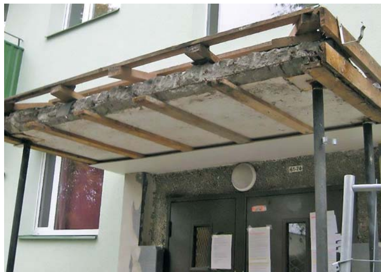
Smagais ieejas mezgla jumts ir nostiprināts, lai novērstu nobrukšanas draudus.
